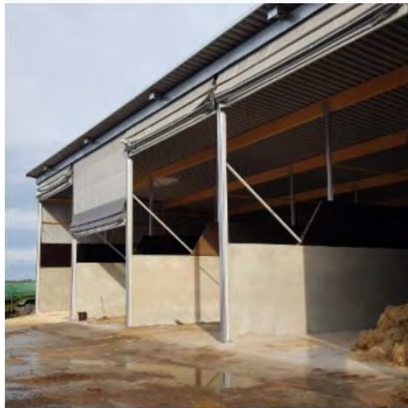
Apekomponenteille umpinainen varasto ja suojaus pressuovilla
