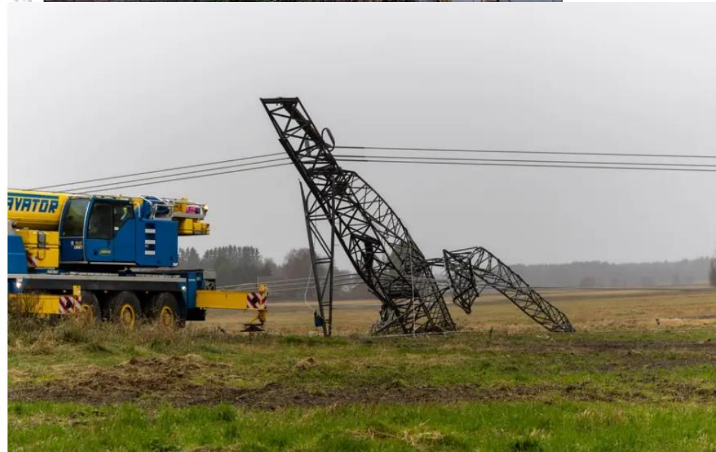
Perjantainen myrsky kaatoi kaksi voimajohtopylvästä pellolle Eurajoella. Pylväät korvataan tulevina päivinä uusilla. KUVA: JUSSI HIETIKKO
